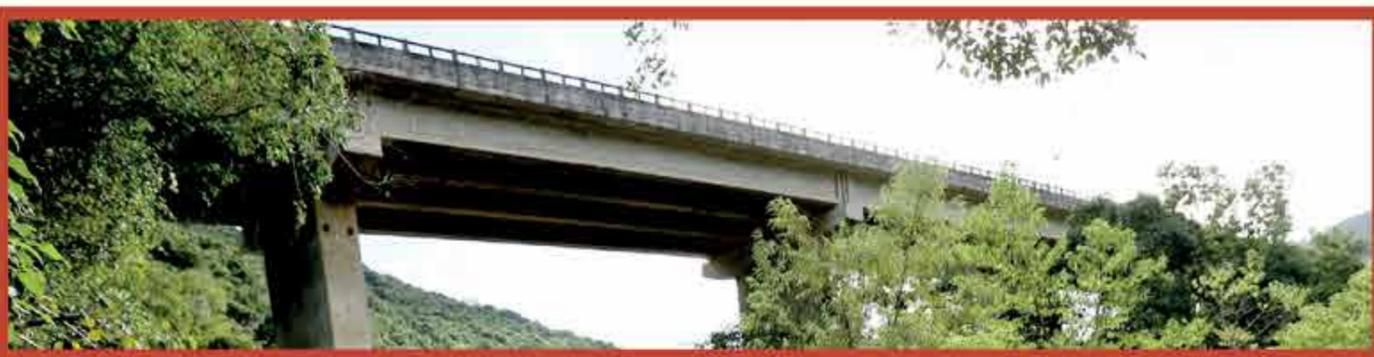
**PONTE SOBRE O ARROIO CARVALHO:** obra de transposição da junção de dois arroios no início da Serra, com 300 m de extensão e pilares de 22 m de altura. A construção da ponte viabilizou a preservação do Sítio Arqueológico "Casa Enxaimel" localizado junto à rodovia.
