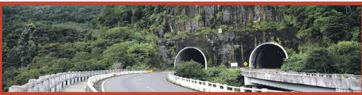
**TÚNEL DA REVERSÃO:** dois túneis construídos em paralelo, interligados entre si. Maior túnel da Rota do Sol, inaugurado em 2006, possui 445,20 m de extensão.
