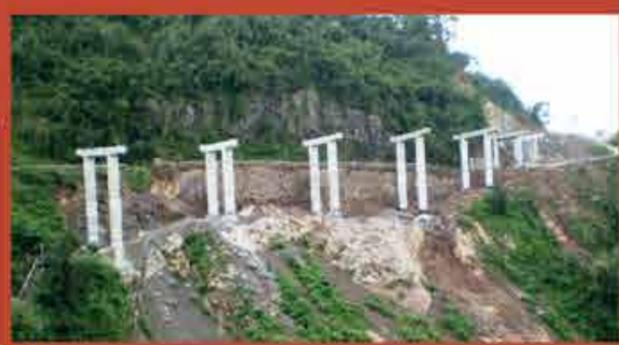
**VIADUTO DA CASCATA:** maior obra da Rota do Sol e última a ser entregue no final de 2007. Possui 340 m de extensão com duas faixas para subida e uma para descida, costeando a Serra do Pinto, com sustentação de 13 pilares. Construído a uma altura de 15 a 30 metros do solo, seu traçado sinuoso (semelhante a um S) impressiona os usuários.
