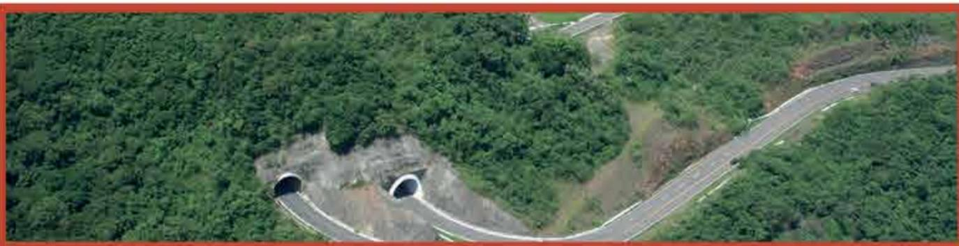
**TÚNEL DO ARROIO CARVALHO:** entregue em 1998, é o primeiro túnel construído na Rota do Sol, sendo pioneiro no estado neste tipo de construção. Possui 388,80 metros de extensão.
